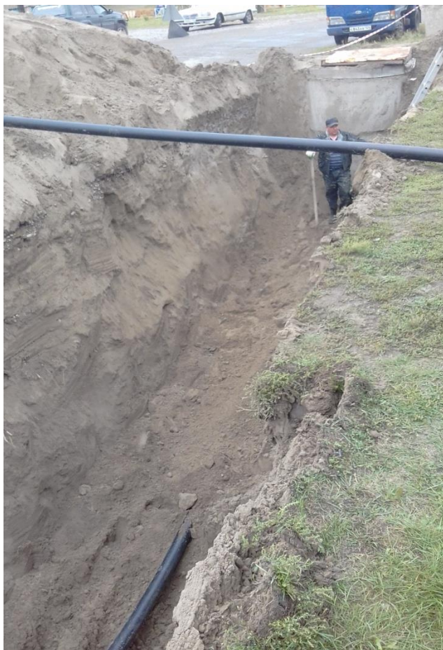
Капитальный ремонт участка водопроводной сети в с. Селиваниха
