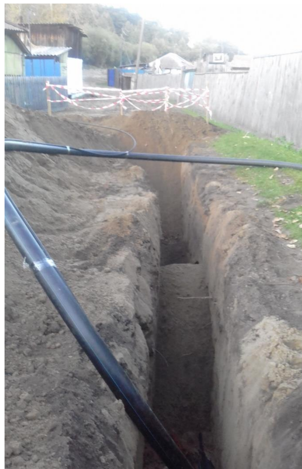
Ремонт сетей водоснабжения в с. Знаменка
