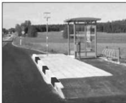
Пример обустройства остановочного пункта пандусом
